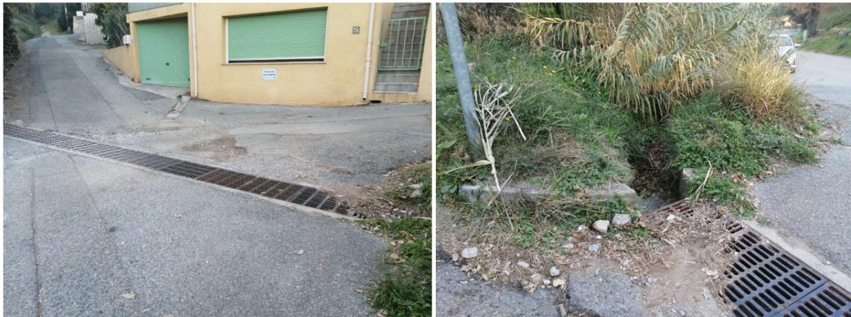
Figure 25. Caniveau à grille et rejet dans le fossé rue Les Maoupas (Source : setec)
